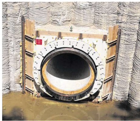
Blick in die Tiefe: Die Arbeiten an den neuen Infiltrationsanlagen im Lorsche Wald schreiten voran. BILD: NIK/A
