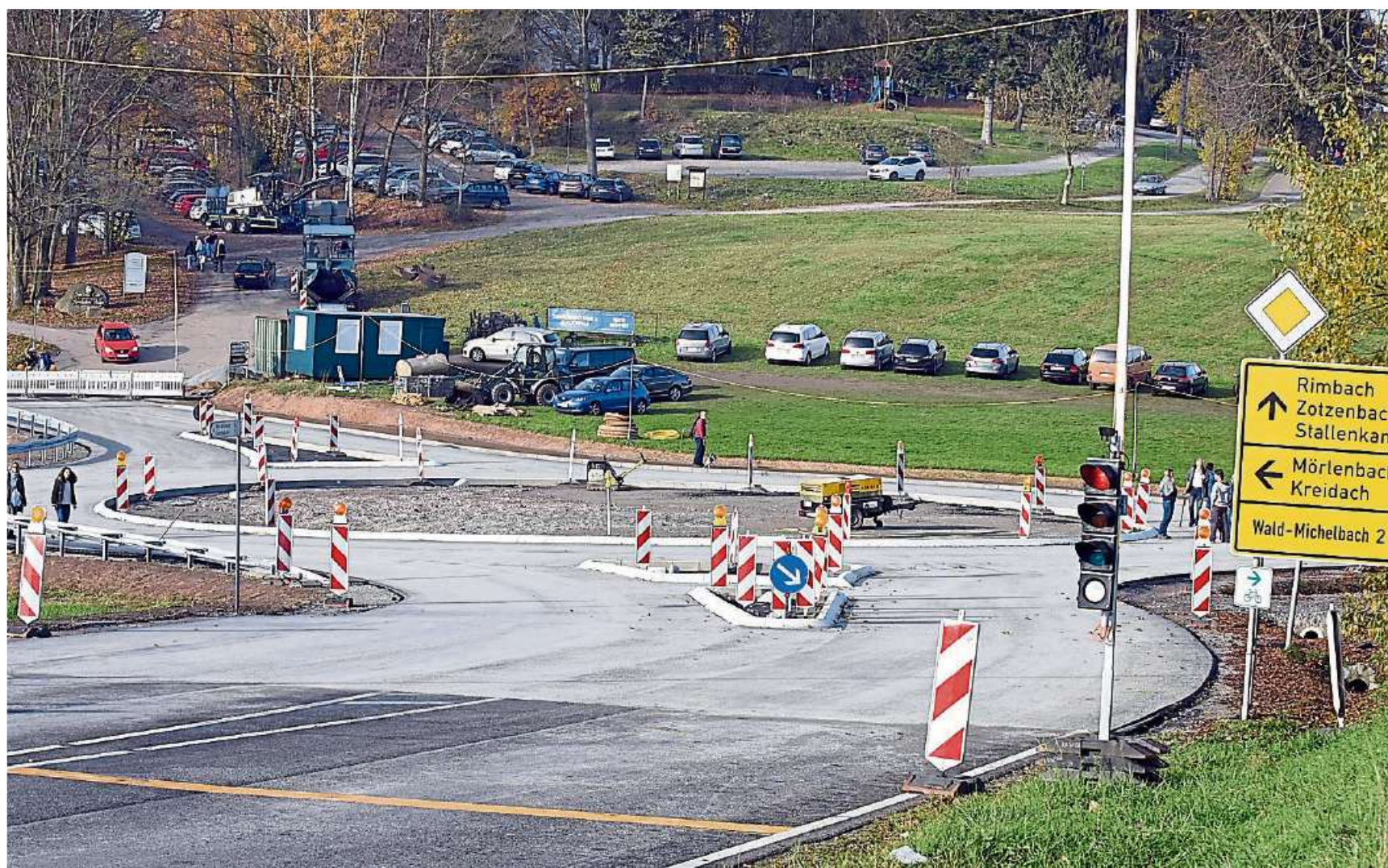
Baustelle: In der nächsten Woche soll der Kreisel auf der Kreidacher Höhe fertig sein. Die Fahrbahnen sind bereits asphaltiert.
