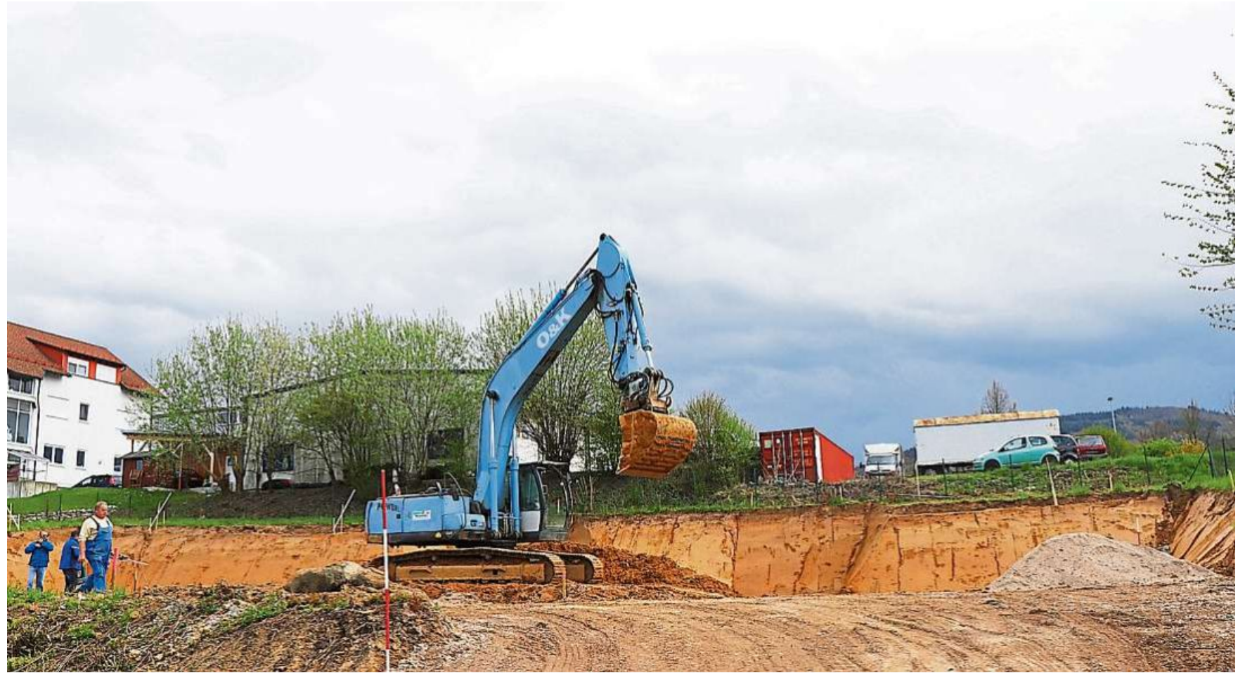
Die Bauarbeiten an der Behindertenwerkstatt Fürth für die neue Tagesförderstätte gehen gut voran.
