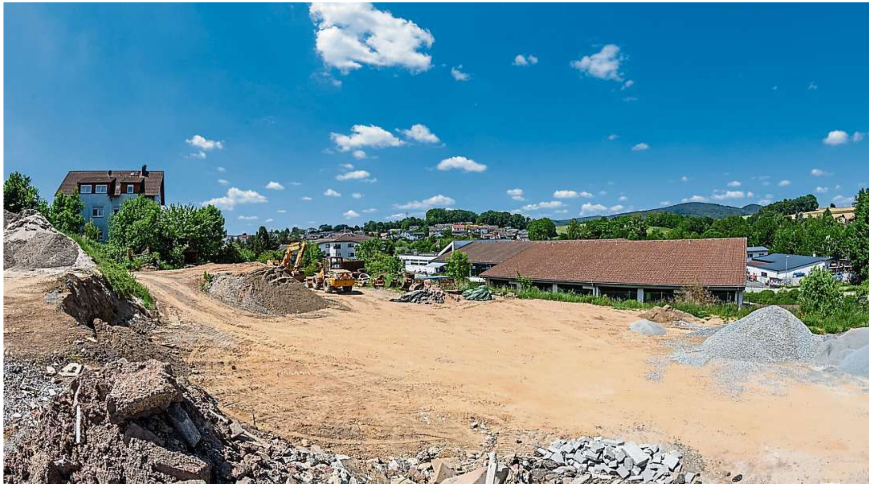
Der Neubau der Behindertenhilfe Bergstraße entsteht nahe dem bereits bestehenden Werkstattgebäude.
