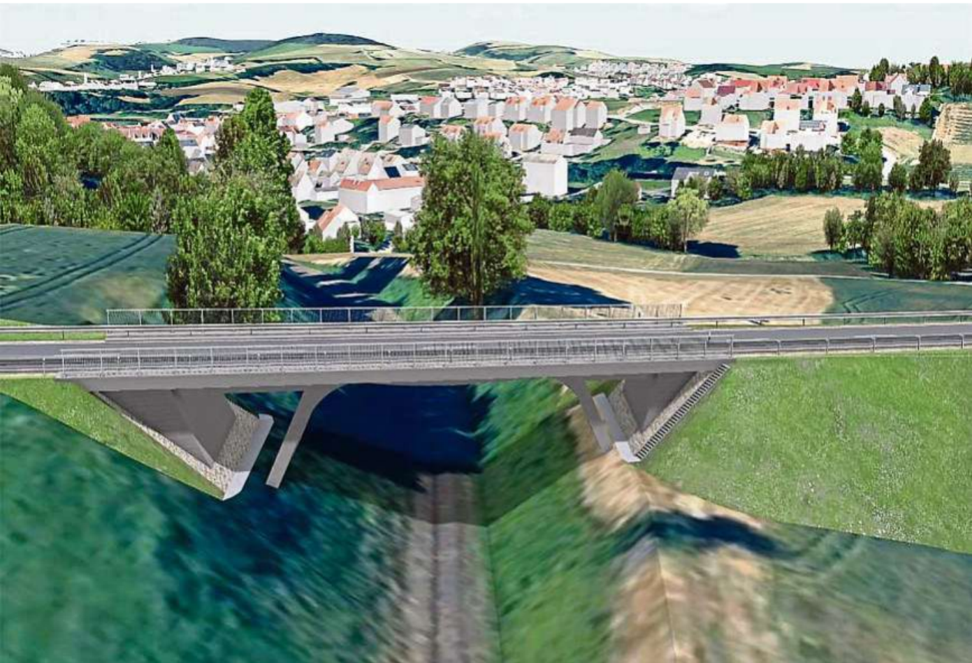
Mit dem Bau der Bücke über die Bahngleise der Überwaldbahn wird am kommenden Montag begonnen.
